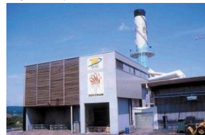
Chaufferie biomasse de Dole
