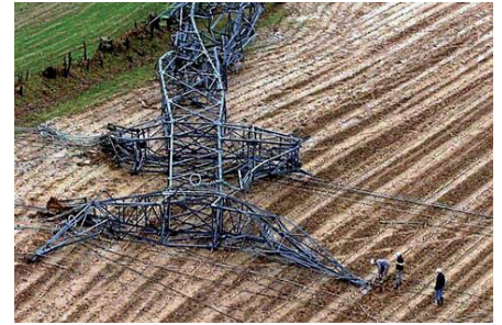
Effondrement d'un pylône en Ille-et-Vilaine - 1999
