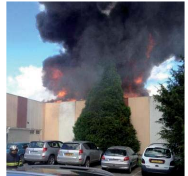
Incendie entrepôt de stockage à Lomme (Nord)
